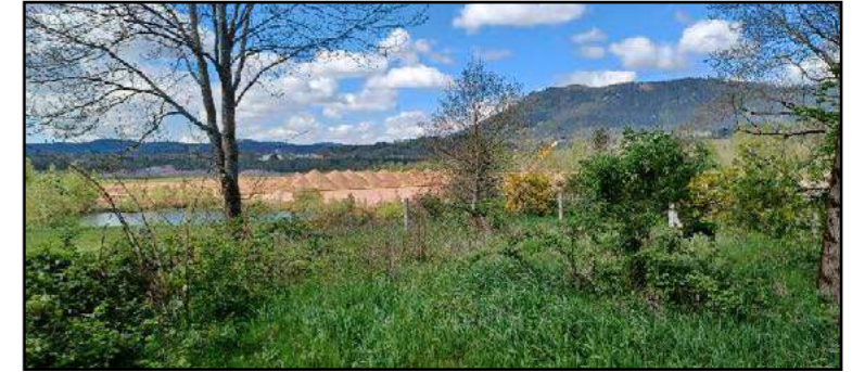
Gravières et sablières de la Sté des BALLASTIERES CANTRELLE qui exploite une carrière à ciel ouvert de granulats alluvionnaires de la Meurthe
