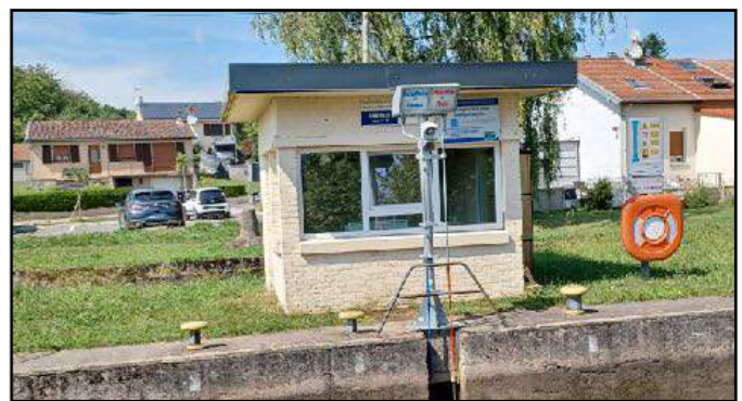
Ecluse n° 21 de Sommerviller
