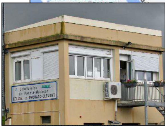
l'écluse de Clévant
