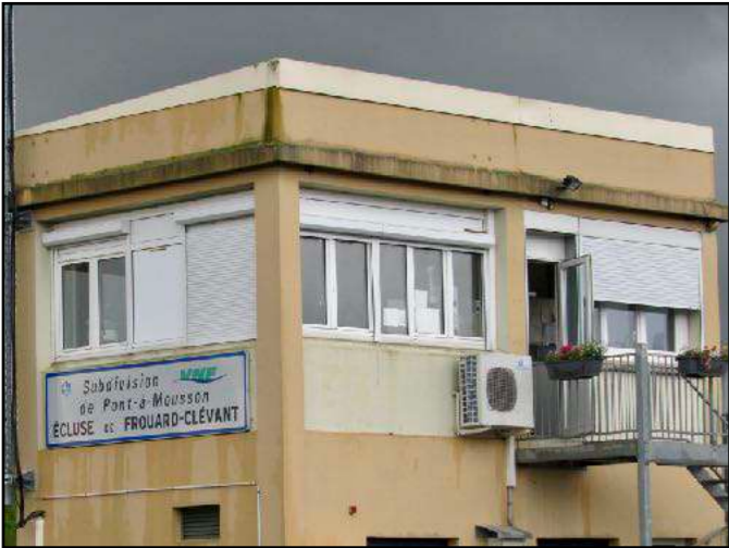
Toute proche : L'écluse N° 27 de Frouard-Clévant, d'une hauteur de 3m et d'une longueur de 120m, est située sur le canal de la Marne-au-Rhin. Elle donne accès au port de Frouard qui est le plus important du département. Elle est aménagée pour recevoir des bateaux type croisières touristiques.
