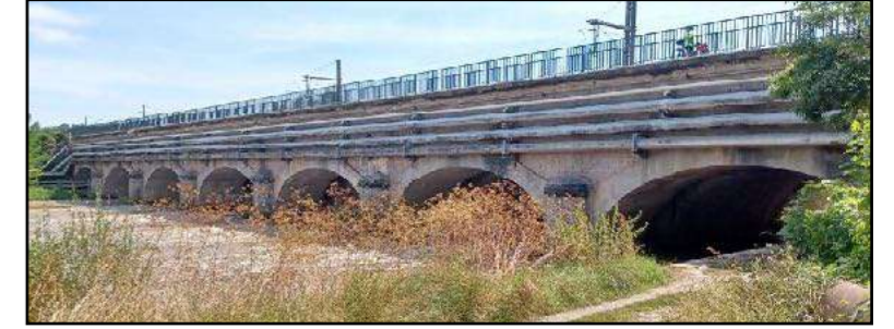
Pont-canal de La Madeleine également dénommé Pont-canal de Saint-Phlin du nom du quartier situé à proximité. Ce pont-canal fut construit en 1852. Il est constitué de 7 arches qui enjambent la Meurthe. Il supporte également les voies ferroviaires de la ligne Paris/ Strasbourg et Nancy / Saint-Dié-des-Vosges fréquentées notamment par les TGV. On aperçoit à l'horizon, au-dessus des champs, la basilique Saint-Nicolas-de-Port.
