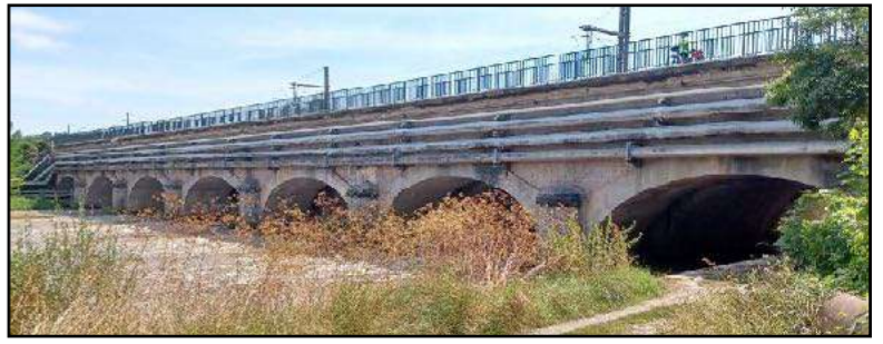
Pont-canal de La Madeleine également dénommé Pont-canal de Saint-Phlin du nom du quartier situé à proximité. Ce pont-canal fut construit en 1852. Il est constitué de 7 arches qui enjambent la Meurthe. Il supporte également les voies ferroviaires de la ligne Paris/ Strasbourg et Nancy / Saint-Dié-des-Vosges fréquentées notamment par les TGV. On aperçoit à l'horizon, au-dessus des champs, la basilique Saint-Nicolas-de-Port.
