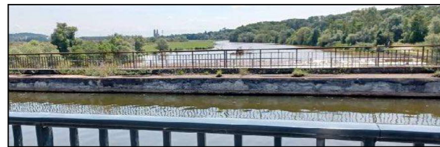
Pont-canal de La Madeleine également dénommé Pont-canal de Saint-Phlin du nom du quartier situé à proximité. Ce pont-canal fut construit en 1852. Il est constitué de 7 arches qui enjambent la Meurthe. Il supporte également les voies ferroviaires de la ligne Paris/ Strasbourg et Nancy / Saint-Dié-des-Vosges fréquentées notamment par les TGV. On aperçoit à l'horizon, au-dessus des champs, la basilique Saint-Nicolas-de-Port.
