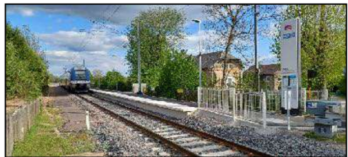
Gare SNCF de Ménil-Flin (Ligne SNCF Nancy / Saint-Dié)
