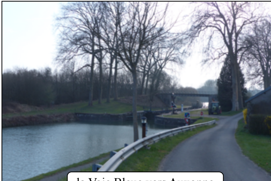
la Voie Bleue vers Auxonne
